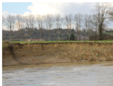
Erosion de l'Adour à Riscle
