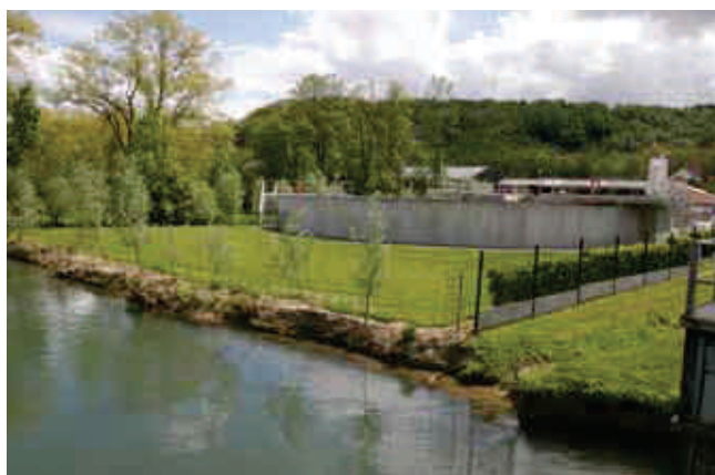
Photo 8 : La station d'épuration de Wizernes.
