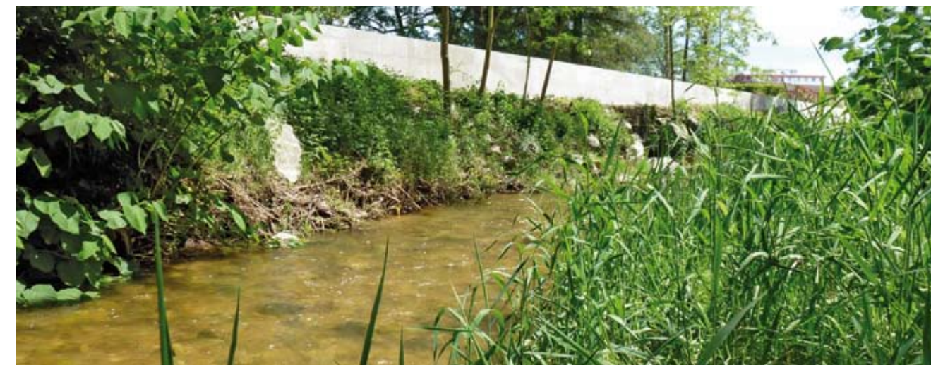
A Grigny, les travaux de protection contre les crues se poursuivent.
