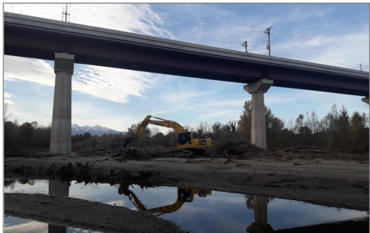
Travaux sur le Tech sous le pont LGV – P11 – 12/2018
