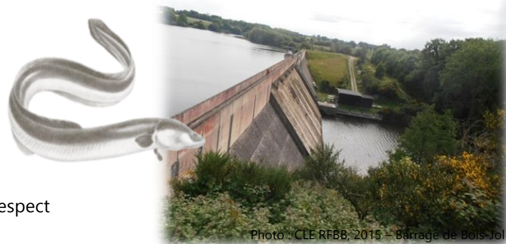
Photo : CLE RFBB, 2015 – Barrage de Bois-Joli
