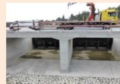
Sur le grand étang de Jugon-les-Lacs, des travaux de réhabilitations de la digue et construction de clapets hydrauliques ont commencé fin août 2014.
