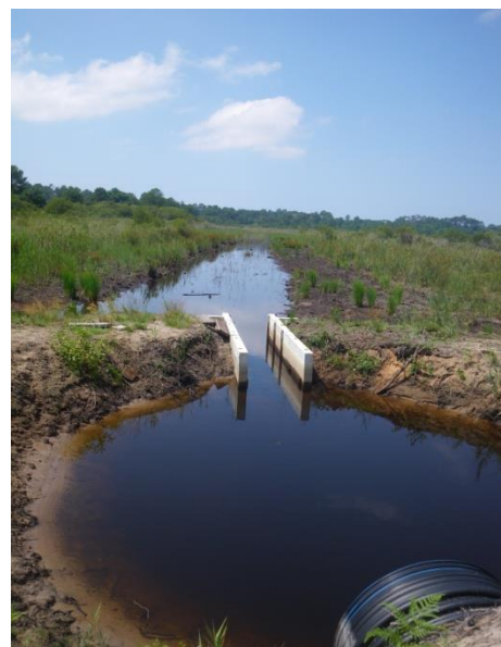
Figure 23 - Ouvrage de régulation hydraulique sur le marais de Laouadie
