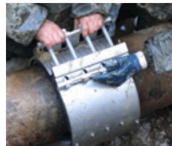
Installation d'un manchon de réparation (source : Norham)
