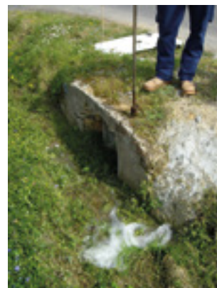
Réalisation d'une purge (source : Irstea)
