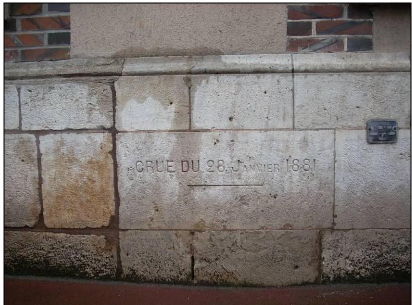
Repère de crue, mur de la mairie de Bonneval. ASCONIT Consultants, 2010
