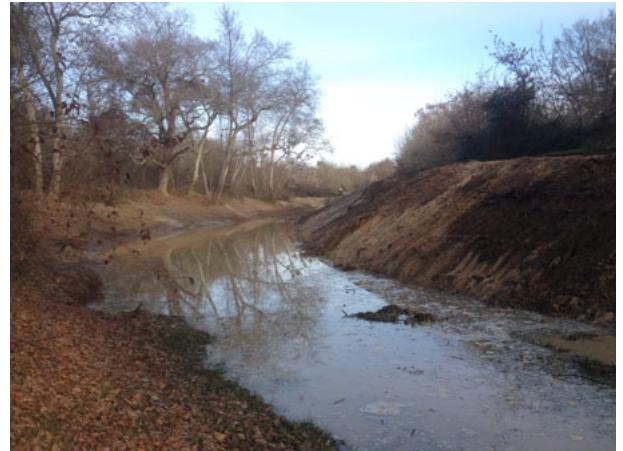
Reconnexion de bras mort, Frayère Saoubin à Carcarès-Sainte-Croix
