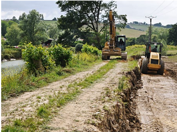
Renforcement de digue
