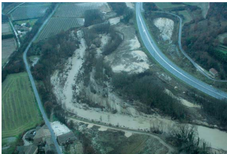
Le Calavon à La Bégude en 2008 : zone d'expansion des crues
