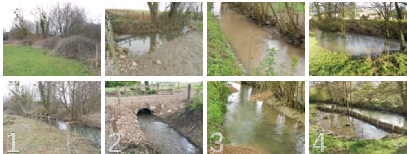
La Même : avant (photos du haut) et après travaux (photos du bas)
