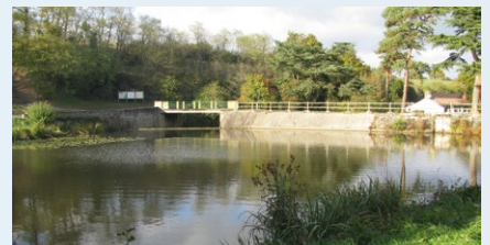
Aval avant travaux
