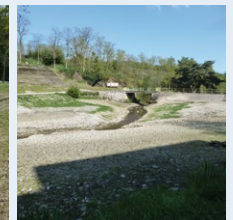
Aval après travaux
