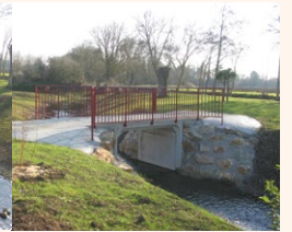
Installation d'une passerelle sur le bras droit réaménagé
