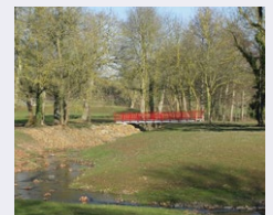
Le clapet a été supprimé et le lit du Layon réaménagé
