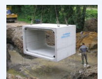
Pose du pont-cadre
