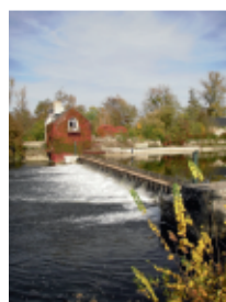
Barrage de Nitray sur le Cher canalisé
