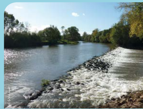
Barrage de Trébusson
