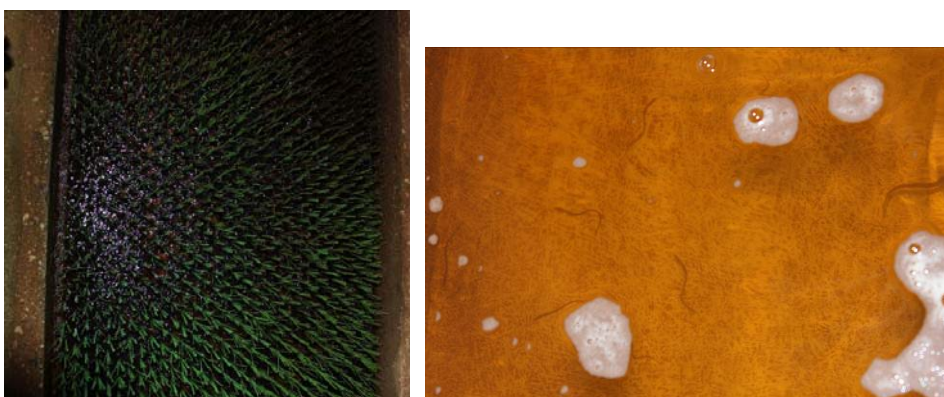
Figure 18 : Brosse inclinée et civelles dans le bac de réception de l'écluse du Pas-du-Bouc
