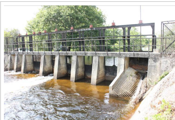
Vue aval de l'écluse de Batejin
