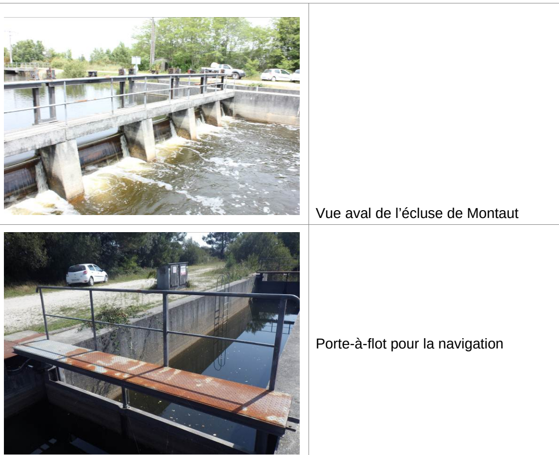
Figure 5 : Photographies de l'écluse de Montaut et des ouvrages annexes
