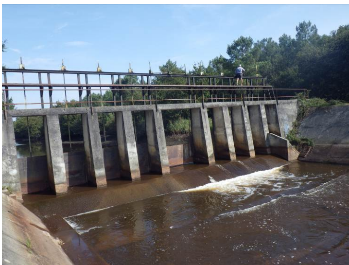
Vue aval de l'écluse de Joncru
