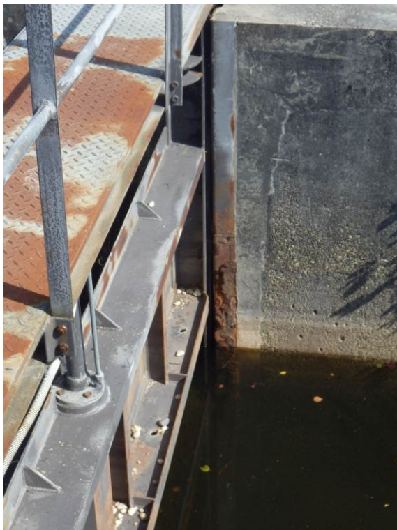
Figure 19 : Corrosion avancée sur la porte-à-flot de l'écluse de Montaut
