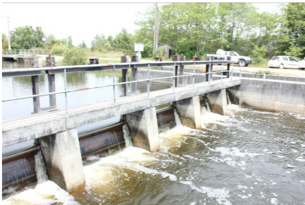
Vue aval de l'écluse de Montaut
