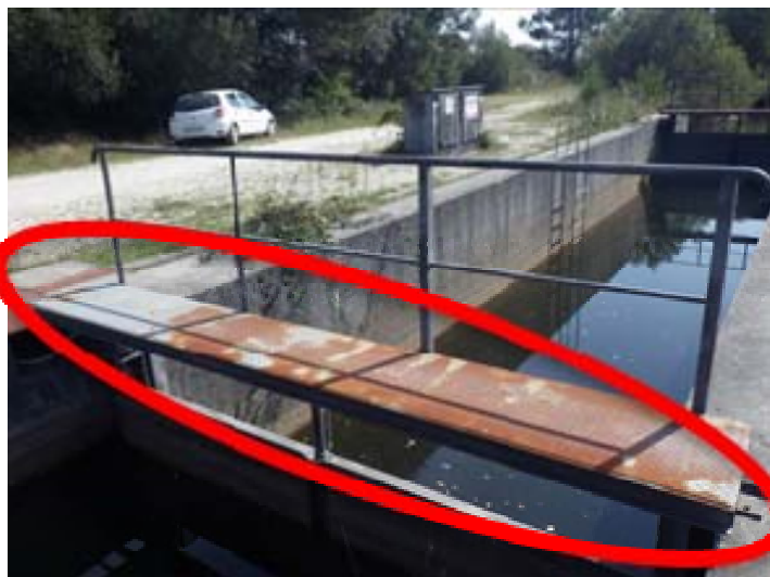
Figure 20 : Absence d'un garde-corps sur la passerelle de la porte-à-flot
