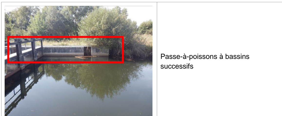
Figure 16 : Photographies de l'écluse de Montaut et des ouvrages annexes
