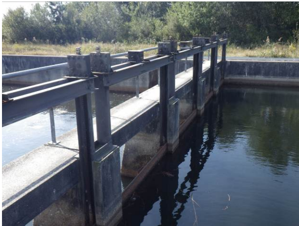
Vue amont de l'écluse de Montaut
