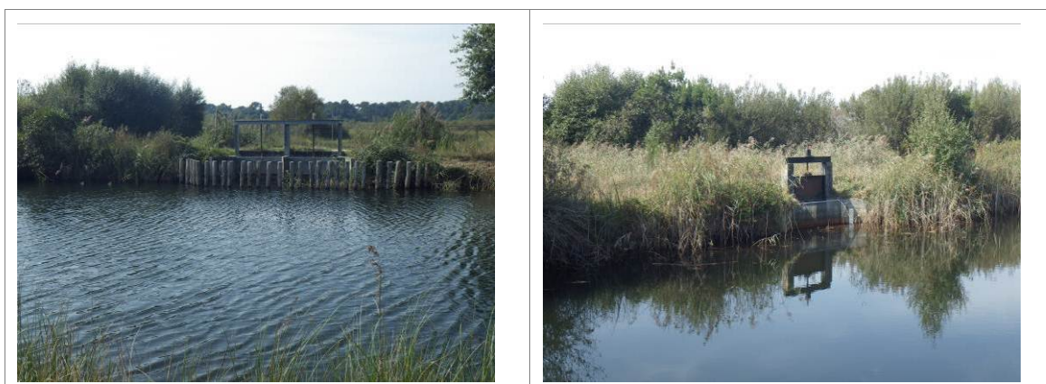
Figure 21 : Photographies des deux prises d'eau vers le marais de Cousseau
