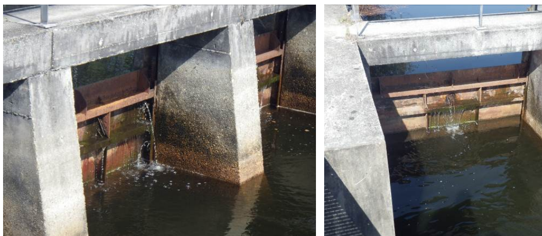
Figure 17 : Fuites dues à la corrosion sur les pelles métalliques de l'écluse de Montaut
