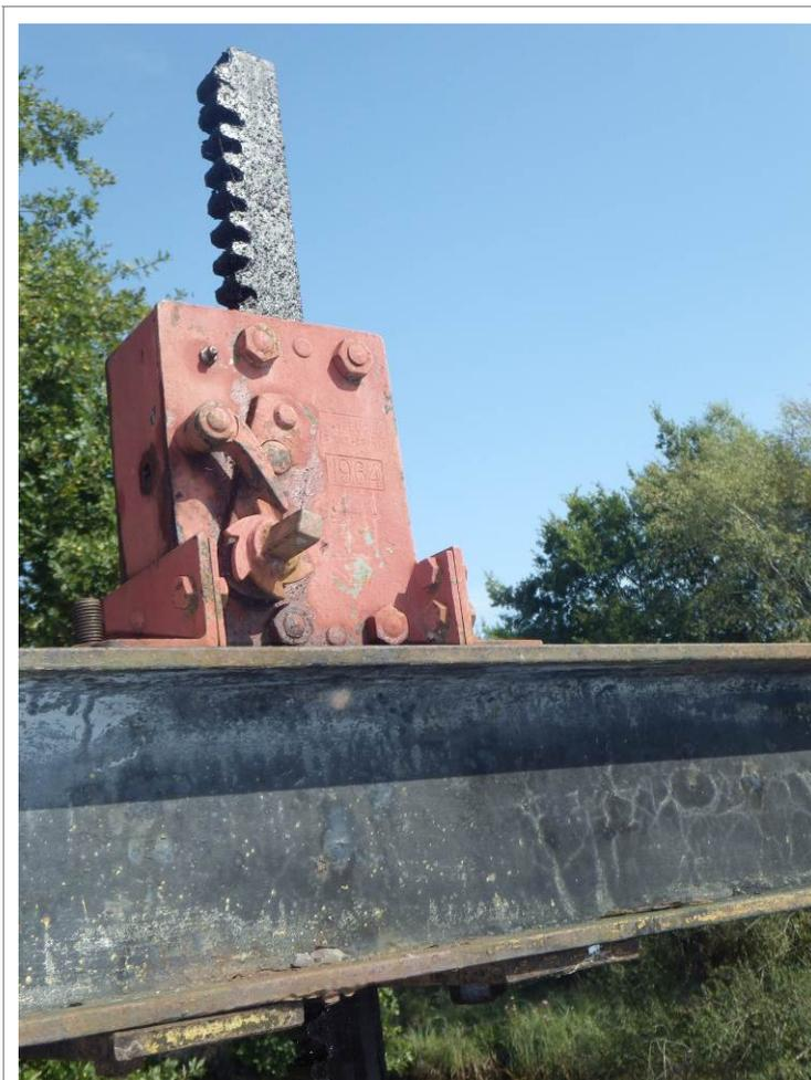
Système de manœuvre non-sécurisé et possiblement bloqué en cas de manque d'entretien
