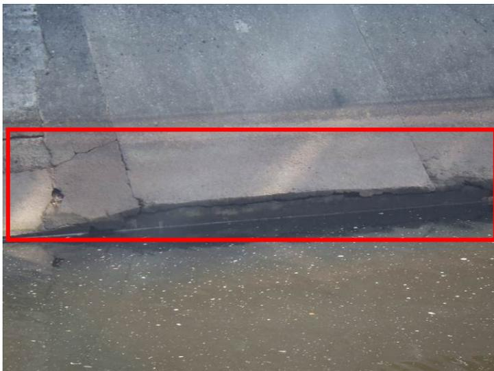
Fissure longitudinale et déstructuration marquée du béton en rive gauche
