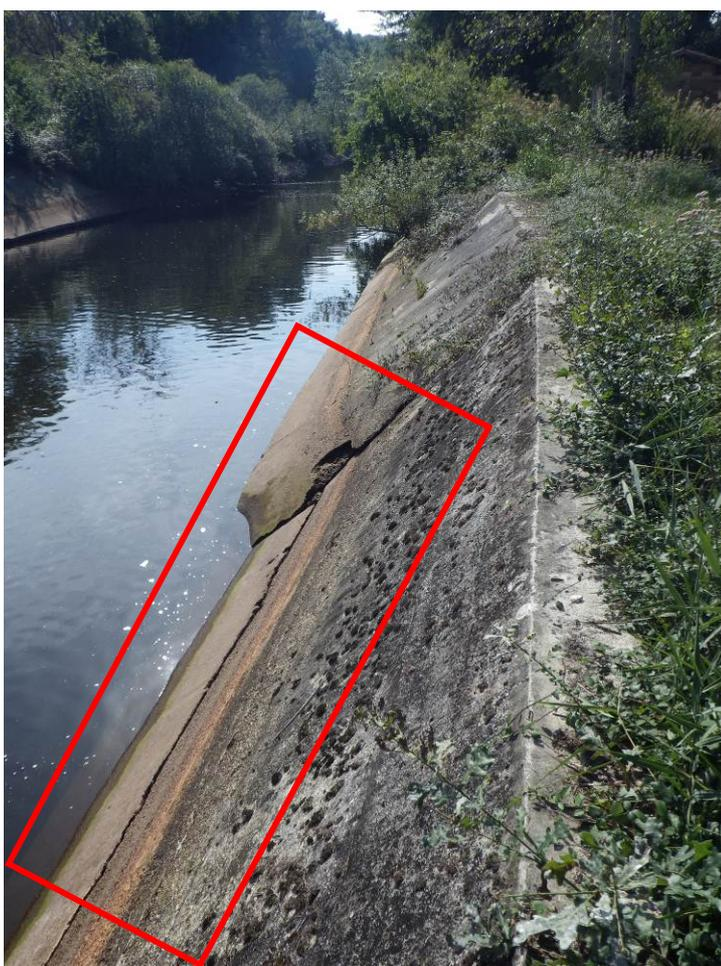
Fissure longitudinale et déstructuration marquée du béton en rive droite au niveau d'un raccord – infiltration d'eau
