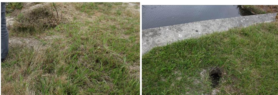
Figure 21 : Affouillements en arrière des murs latéraux en béton
