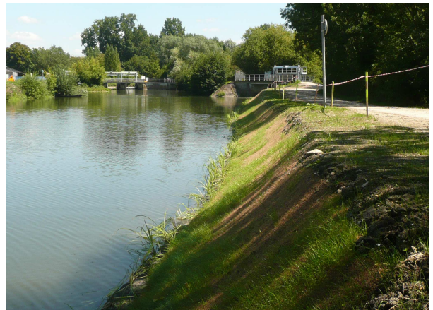
Etat projeté à la fin des travaux
