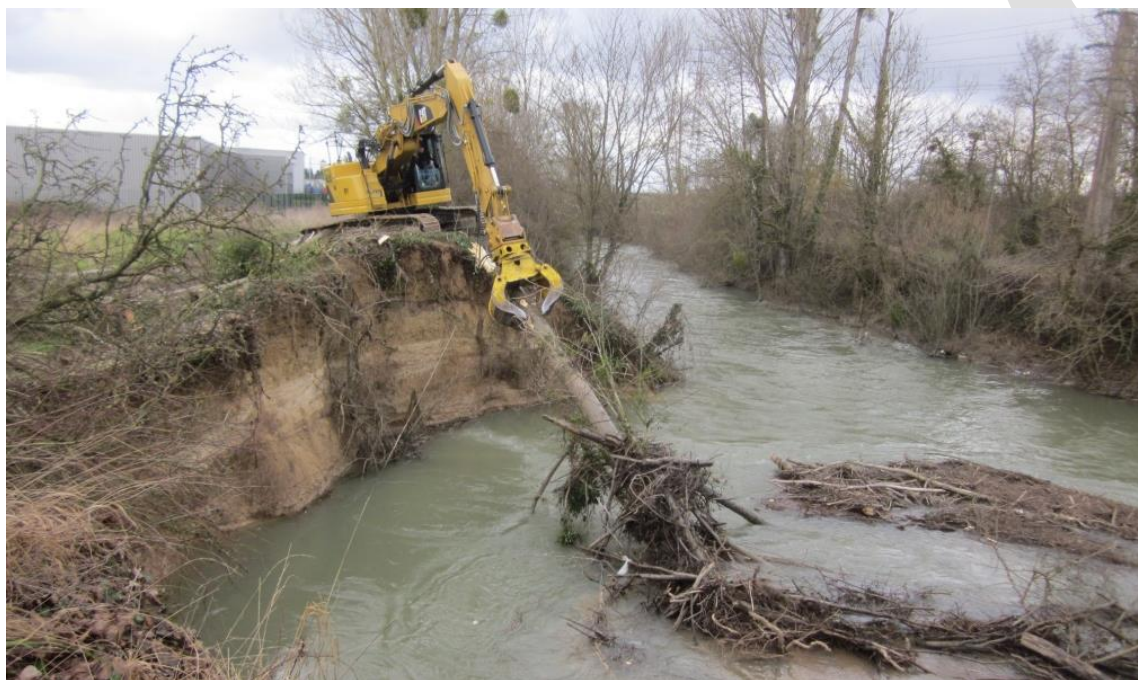
FIGURE 36: TRAVAUX DE RETRAIT D'EMBACLES AU DROIT D'UNE IMPORTANTE EROSION DE BERGE (LA TILLE A GENLIS - 2014)
