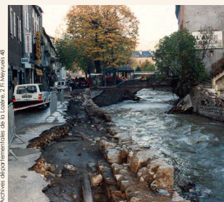
Passerelle de Linas après la crue du Cernon, novembre 2014.
