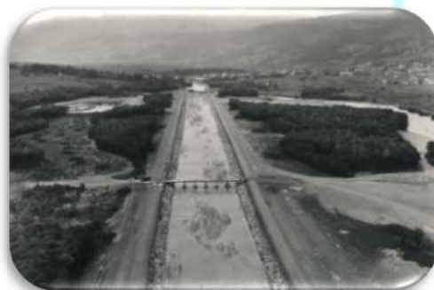
Endiguement de l'Arve à Sallanches
