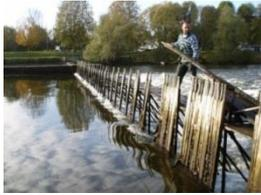
Objectif du maintien des barrages à aiguilles sur le Cher canalisé et d'un aménagement par sections de biefs.
