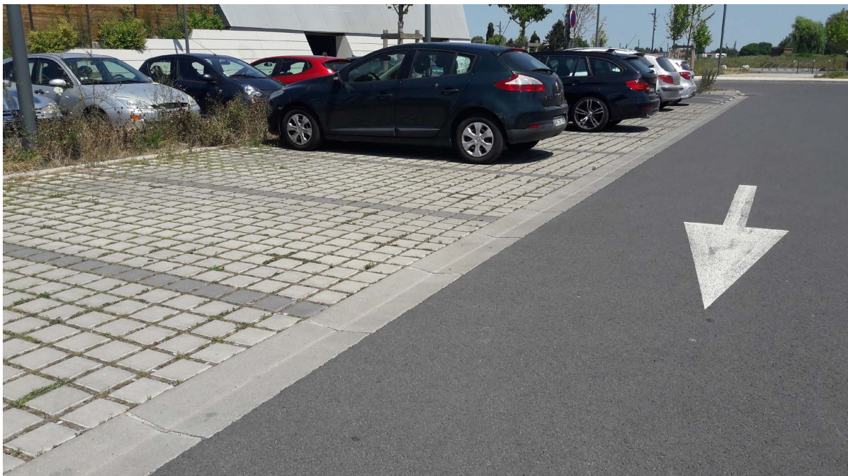
Parking permettant l'infiltration des eaux pluviales à Douai (59) - M. Rymek
