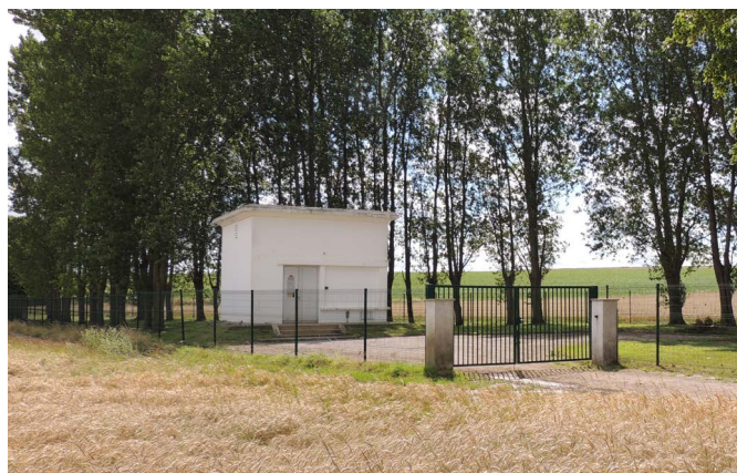
Protection du captage d'Eperlecques - D. Devallez
