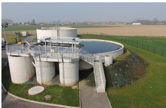
Assainissement collectif - D. Devallez
