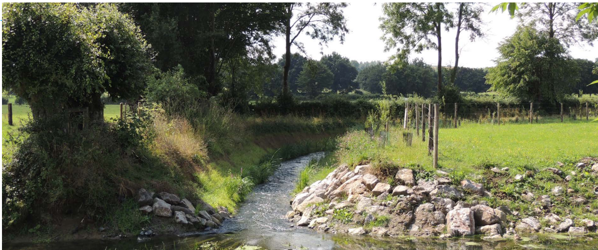
Restauration de la continuité écologique à St Hilaire sur Helpe (59) - D. Devallez
