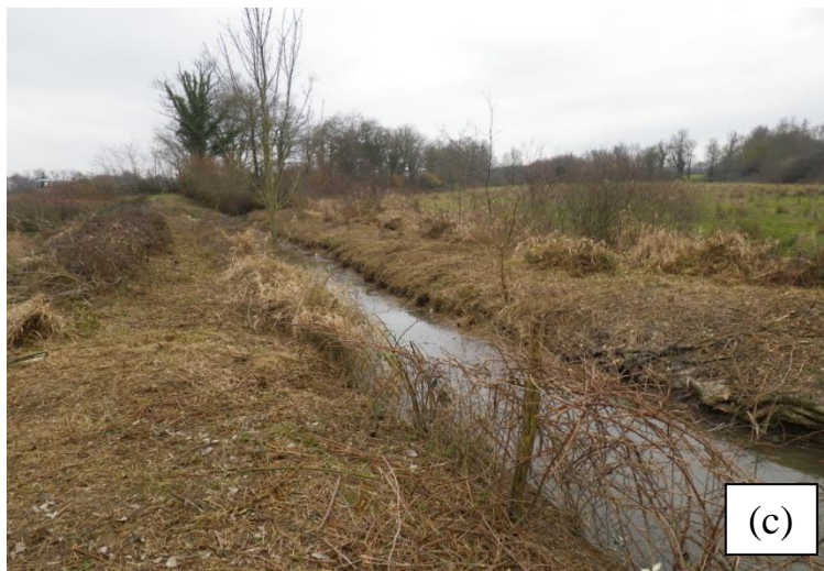
Figure 12 : illustration des différents types de travaux réalisés pour la restauration des fossés : a) reprofilage (curage) ; (b) restauration de la ripisylve (abattage, élagage, enlèvement des embâcles) ; (c) débroussaillage (Source : SRTC)
