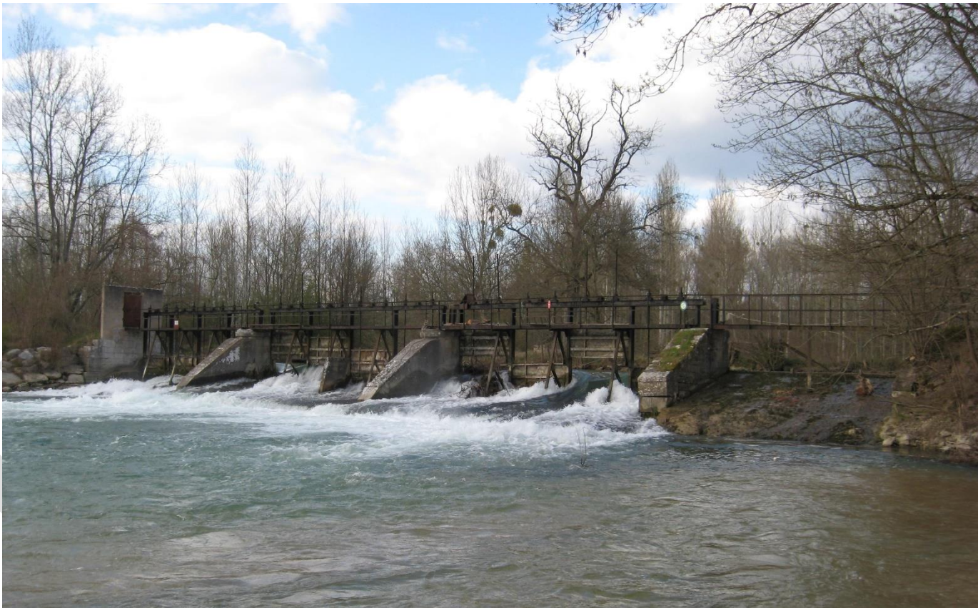
FIGURE 31: BARRAGE DU MOULIN DE CHAMPDOTRE RESTAURER ET EQUIPE EN 2015 POUR LA PRODUCTION D'HYDRAUELECTRICITE
