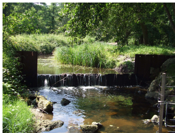
Photo 14 : Dessableurs sur le Moron et en aval du château du Breuil sur la Jalle du Breuil. Source: M.I.G.A.DO.
