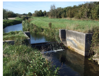
Photo 14 : Dessableurs sur le Moron et en aval du château du Breuil sur la Jalle du Breuil. Source: M.I.G.A.DO.
