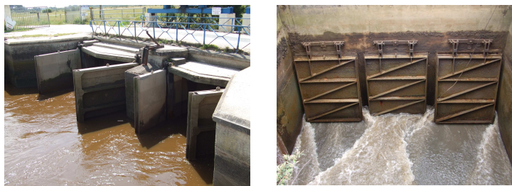
Photo 9 : Portes à flots sur le chenal du Gua et clapets sur la Jalle du Breuil. Source : M.I.G.A.D.O.
