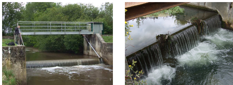
Photo 11 : Clapets mobiles sur le Moron et sur le Taillon en amont de l'étier de Maubert. Source : M.L.G.A.DO.
