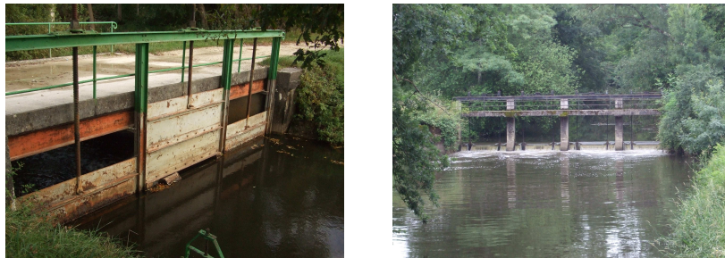
Photo 10 : Vannes situé sur la Jalle du Sud et vannes en aval de la Jalle de Blanquefort. Source : M.L.G.A.DO.
