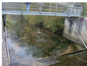
Photo 12 : Clapet sur le Moron en position basse. Source: M.L.G.A.DO.
