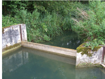
Photo 13 : Batardeaux sur le Taillon (Etier de Maubert). Source: M.I.G.A.DO.
