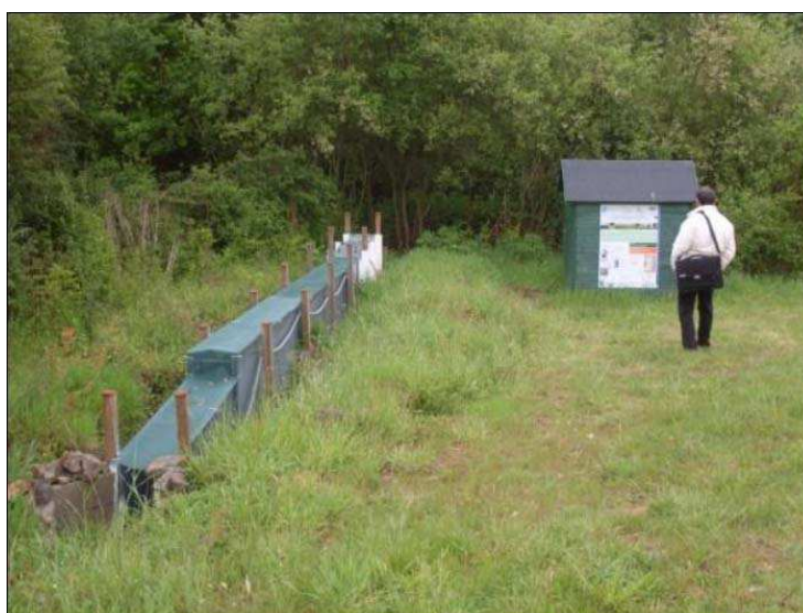
Figure 17 : Le canal d'approche et la cabane de la station hydrologique qui comporte un poster d'explication de l'étude réalisée et des principaux financeurs.
