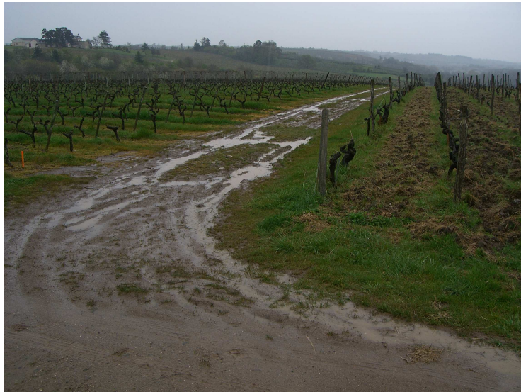
Figure 27 : Liaison entre le chemin de haut de parcelle et le chemin entre la parcelle B (à gauche) et C (à droite). Source : Romain Vallée, 2009.
