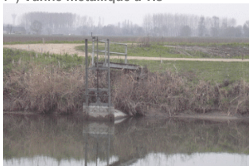
7°) Vanne métallique à vis
