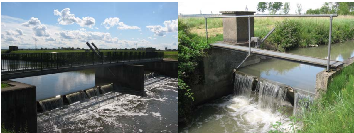
Figure 2.2 : Photographies de clapets semi-automatiques sur l'Authion (gauche) et le Lane (droite)
