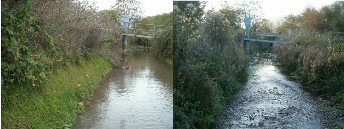
Figure 5.1 : Abaissement d'un clapet (à droite) sur le Couason – Pont de Singé (source SIAC)
