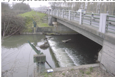
4°) Clapet automatique avec cric crémaillère
