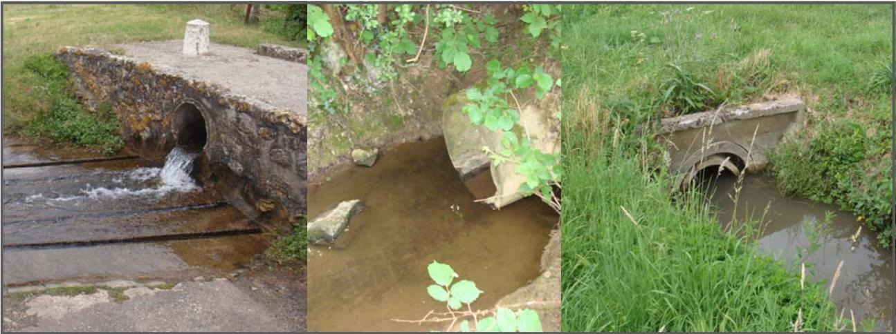
Fig. 7. De gauche à droite : La Calabrière passant dans une buse surélevée puis sur une chaussée, Bassin de l'Huisne ; Buse surélevée sur le Sarthon, Bassin Sarthe Amont ; buse sous-dimensionnée sur un affluent de l'Orne Saosnoise, Bassin Sarthe Amont. (Henner R., 2013)
