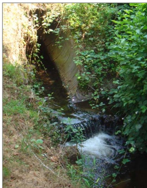
Fig. 42. Seuil à la sortie d'une buse sur la Hune, TdBV n°299 337. (Henner R., 2013)
