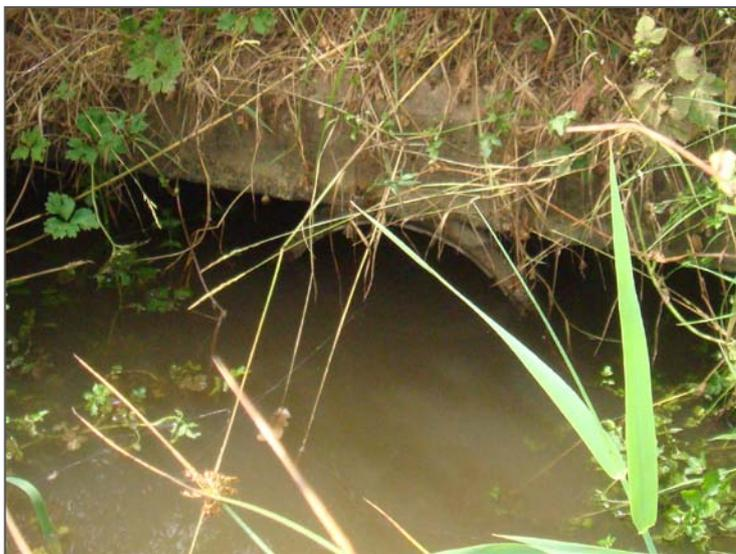
Fig. 59. Buse sous-dimensionnée, eau troublée par un apport important de sédiments fins, cours d'eau du Chêne Vert à l'aval de la TdBV (Henner R., 2013)
