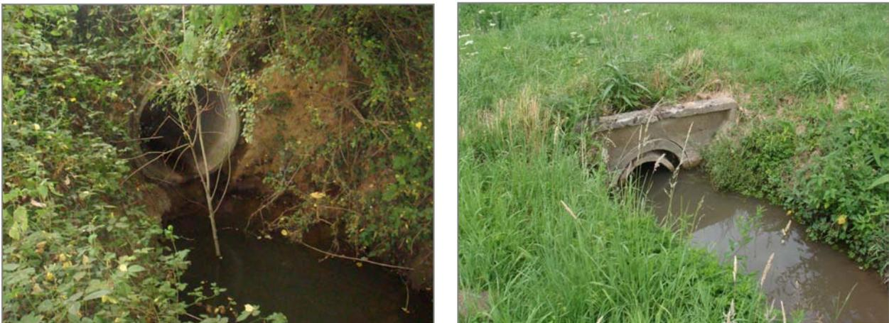
Fig. 72. Ouvrages constituant un obstacle au libre écoulement, buse surélevée et buse sous-dimensionnée, cours d'eau de la TdBV n° 157 709. (Henner R., 2013)
