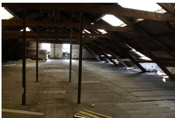
A gauche : grenier du bâtiment en granit
