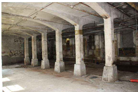
Décassement du sol
