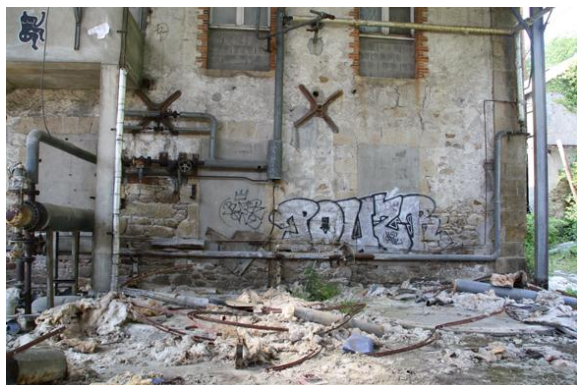
Reprise des ouvertures
