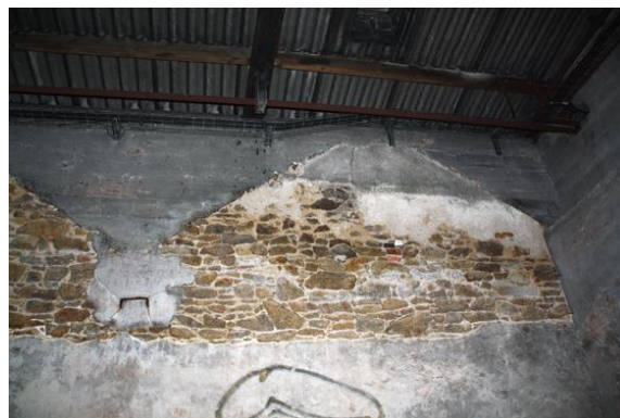
Rehaussement du bâti
