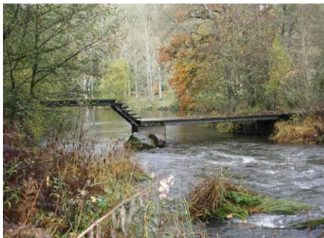
Passerelle en place
