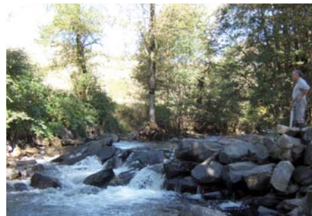
Seuil de la conduite d'eau potable
