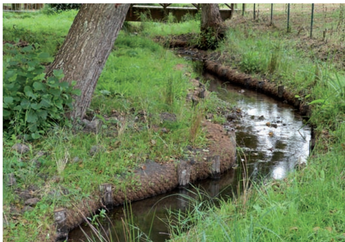
La Merize (Ardenay-sur-Merize) après les travaux de renaturation
