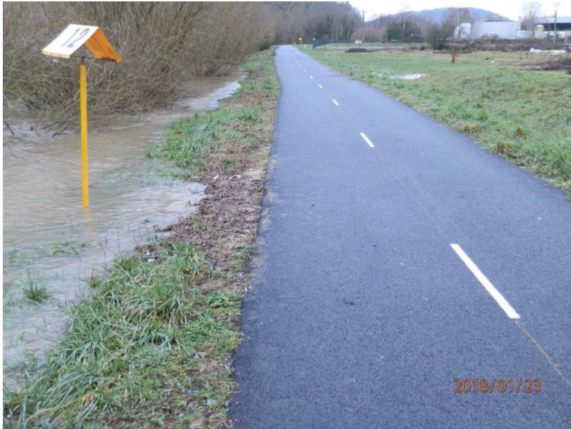
Digue PL8 à Audincourt
