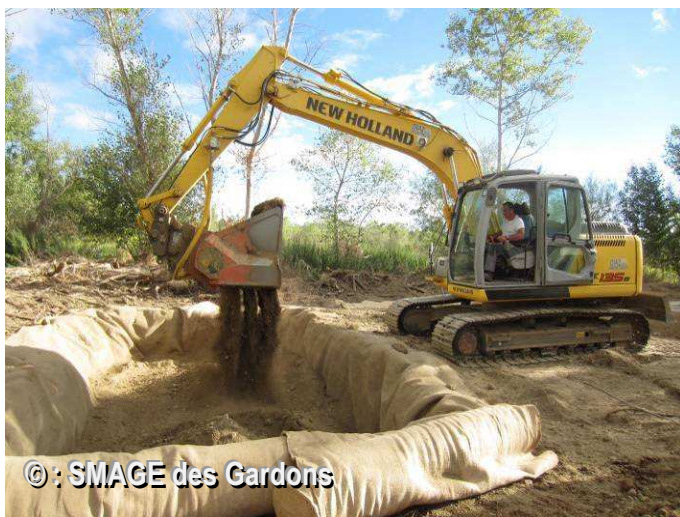
© : SMAGE des Gardons Le dernier broyage s'effectue directement dans la fosse d'extraction
