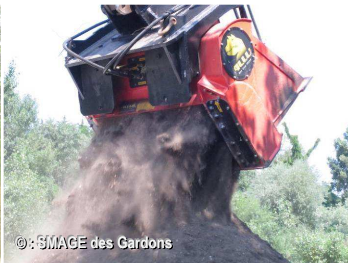
1 ère étape : broyage des matériaux en 2 à 3 passes dans le godet. Le 1 er broyage s'effectue sur une place de dépôt jouxtant le trou.
