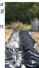
Installation du Venturi
