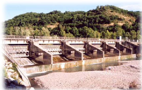
Barrage EDF de Malijai
