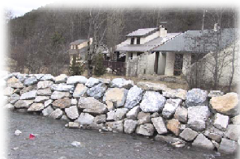
Berge aménagée le long du Bès au Vernet
