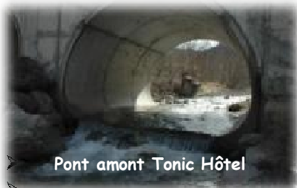
Partie amont de la couverture
