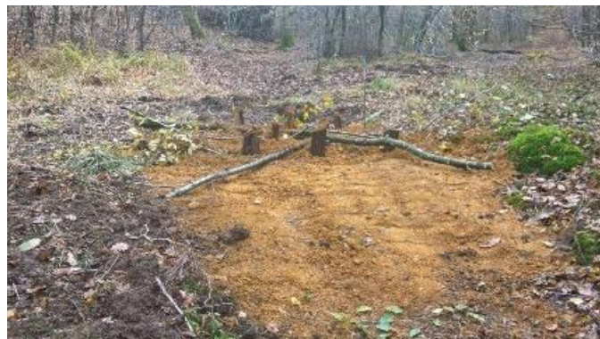
Figure 4 Lutte contre érosion par reconstitution d'embâcles © ONF - F SASSARD
