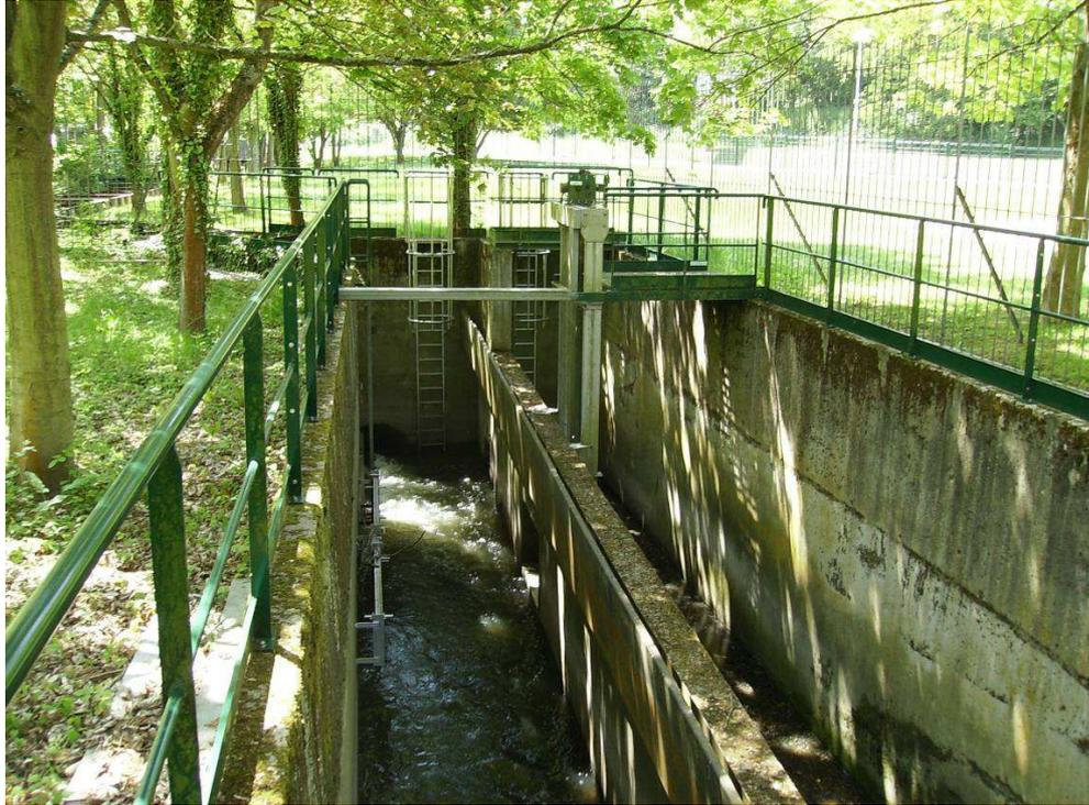
**Figure 20 : Ouvrage de partition des débits à l'amont du bassin d'Antony**
