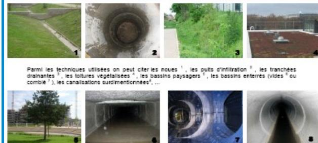
Parmi les techniques utilisées on peut citer les noues<sup>1</sup>, les puits d'infiltration<sup>2</sup>, les tranchées drainantes<sup>3</sup>, les toitures végétalisées<sup>4</sup>, les bassins paysagers<sup>5</sup>, les bassins enterrés (vides<sup>6</sup> ou comble<sup>7</sup>), les canalisations surdimensionnées<sup>8</sup>, ...
