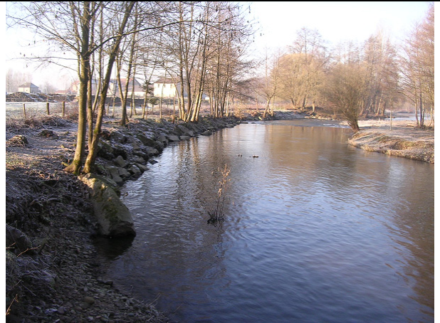
Figure 82 : Enrochements de berges dans la traversée de Breuches
