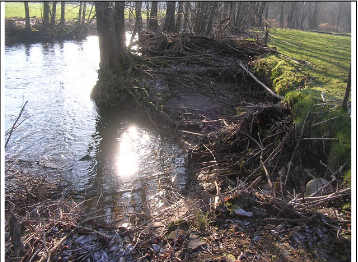
Figure 104 : Erosion de berge et dépôts d'embâcles en aval d'un secteur aménagé
