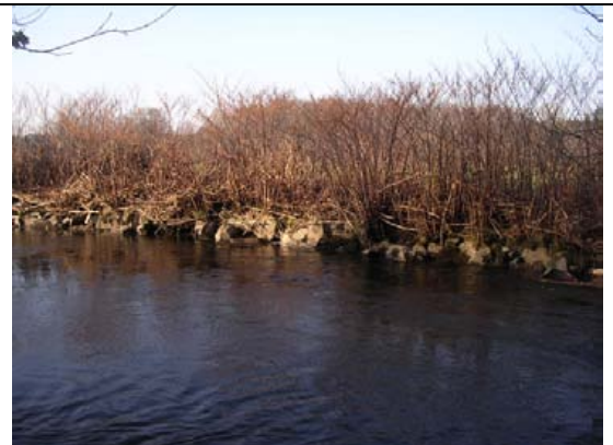
Figure 102 : Enrochement en zone naturelle
