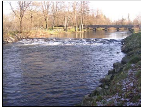
Figure 22 : Seuil de stabilisation sur la Lanterne à Briaucourt
