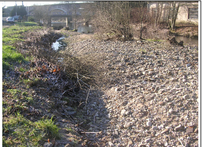
Figure 106 : Vaste cône alluviale au sein du lit mineur et comblement du chenal d'écoulement
