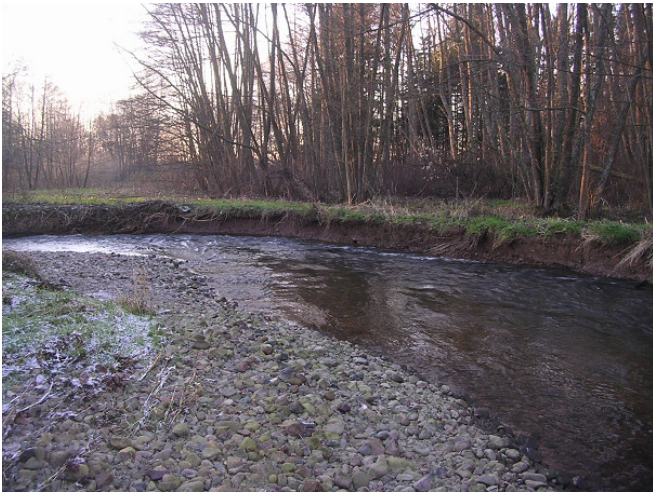
Figure 75 : Dépôts massifs et érosion en amont de la déviation de la N57 à Saint-Sauveur
