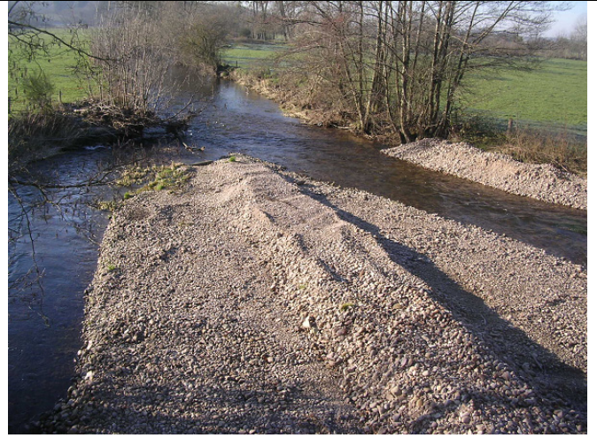
Figure 94 : Atterrissement en aval du pont de la déviation de la RD64
