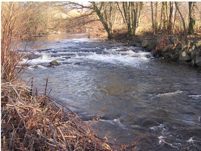
Figure 103 : Seuil de stabilisation du fond du lit
