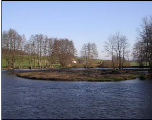
Figure 36 : Atterrissement en amont du seuil de Conflans-sur-Lanterne
