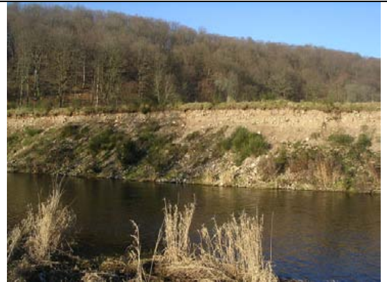
Figure 73 : Importante érosion en rive droite à Froideconche
