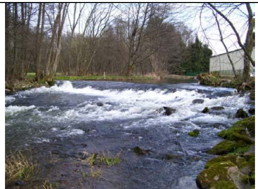
Figure 91 : Seuil de stabilisation à Fougerolles-le-Château au droit de la distillerie
