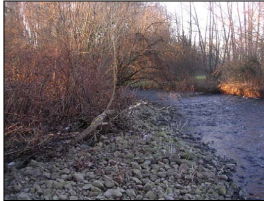
Figure 38 : Atterrissement en amont de la déviation à Froideconche
