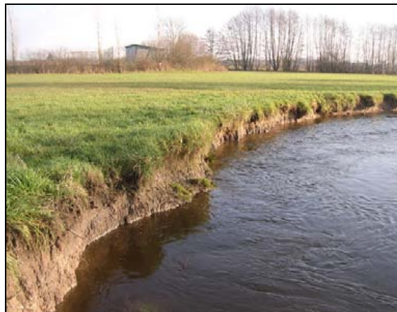
Figure 28 : Erosions de berges caractéristiques dans le secteur de Baudoncourt
