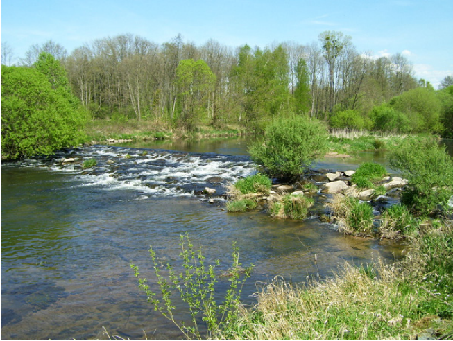
Figure 80 : Seuil de stabilisation du Breuchin
