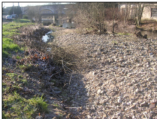
Figure 42 : Important dépôt de matériaux à la confluence Augronne/Semouse (Aillevillers)
