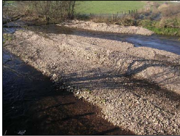
Figure 43 : Atterrissement sous le pont de la D64 à Fontaine-les-Luxeuil
