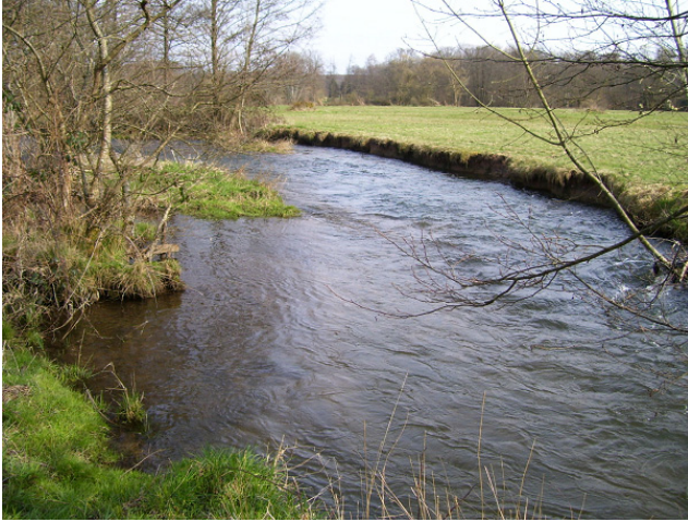
Figure 93 : Erosion de berge non problématique
