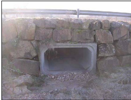
Figure 44 : Passage en partie comblé sous la D64 à Corbenay
