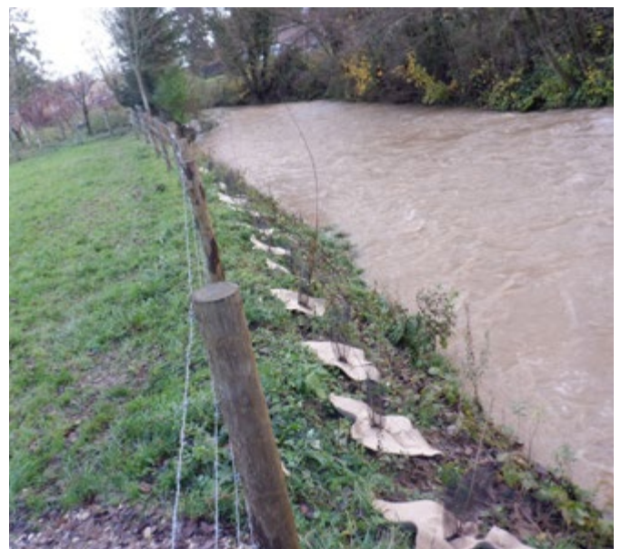
Photo 4 : Travaux de restauration des berges
