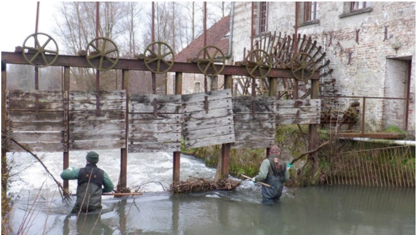
Photo 7 : Entretien d'un ouvrage
