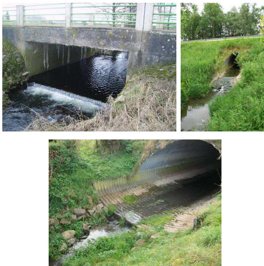
*Fig. 48. EXEMPLES DE RUPTURE ALTIMETRIQUES EN AVAL DE RADIERS DE PONTS*
