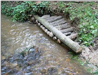
Sous-berge avec petite encoche dans la berge existante, avant recouvrement par de la terre végétale.
