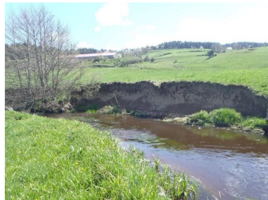
Figure 20 : Erosion sur la Seuge (EP Loire)
