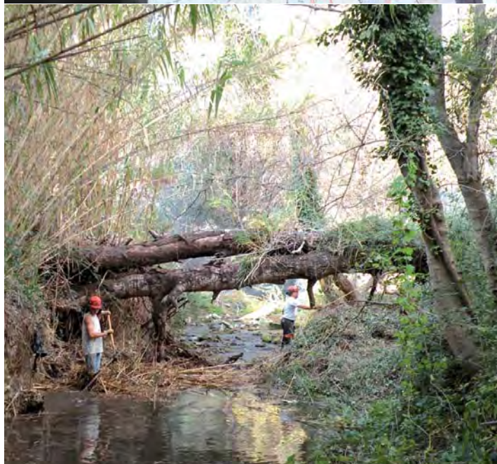
Travaux d'entretien de la rivière
