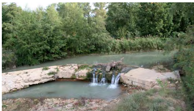
Seuil de Châteauvert (Viens)
