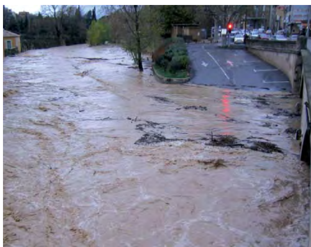
Crue de 2003 à Apt
