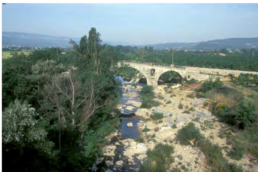
Pont Julien à Bonnieux
