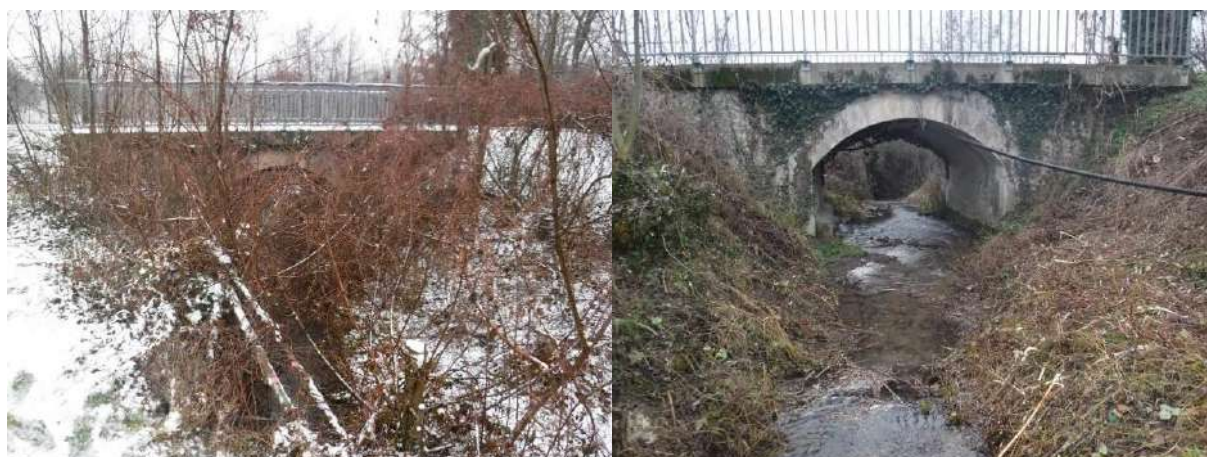
Figure 2 : Un pont sur le ruisseau de Bessins avant et après les travaux d'entretien.
