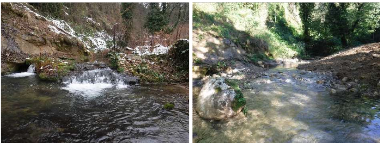
Figure 5 : Effacement d'un seuil créant un obstacle à la continuité écologique sur le ruisseau du Tréry. Photos avant/après travaux.
