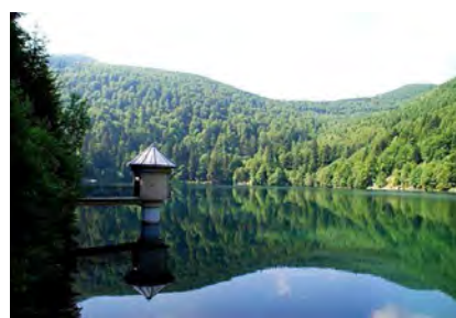
Barrage du Ballon :
