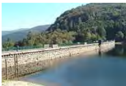
Barrage de la Lauch :
