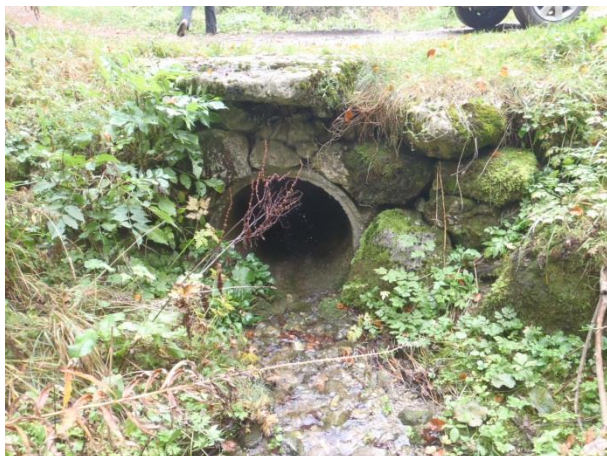
Ouvrage FOL.1 au niveau de Chez Favier
