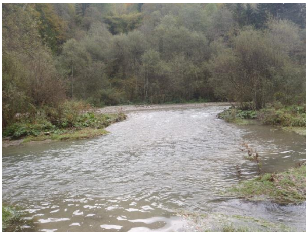
Configuration d'un lit proche de l'anastomose en amont immédiat du barrage de stabilisation
