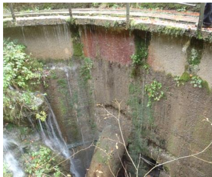
Barrage hydroélectrique à Bellevaux (BreT5)
