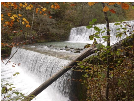
Seuils de stabilisation sur le Brevon
