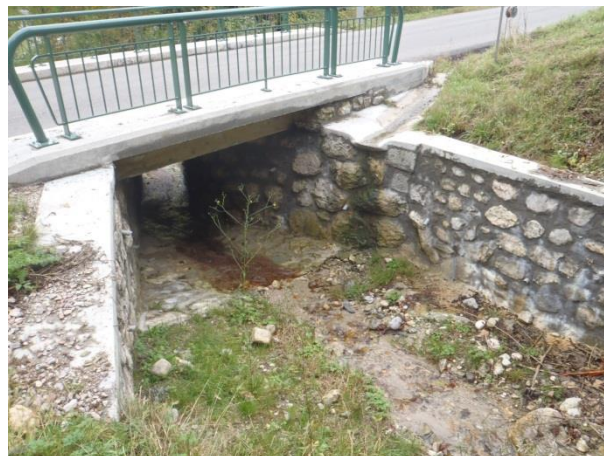
Ouvrage FOL.2 au niveau de la traversée de la D32
