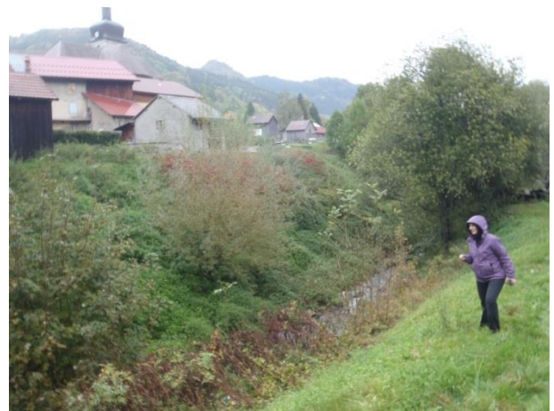
Traces d'anciens travaux de rectification à Lullin
